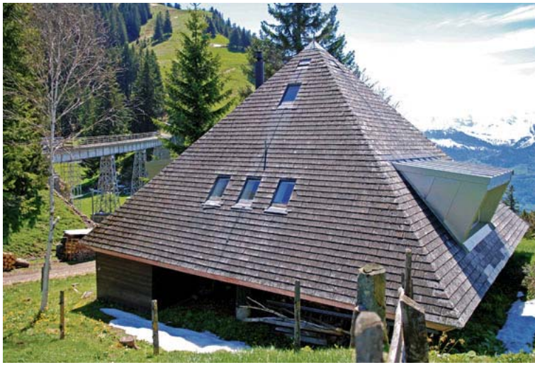
Professor Dahindens erstes Haus auf Unterstette
