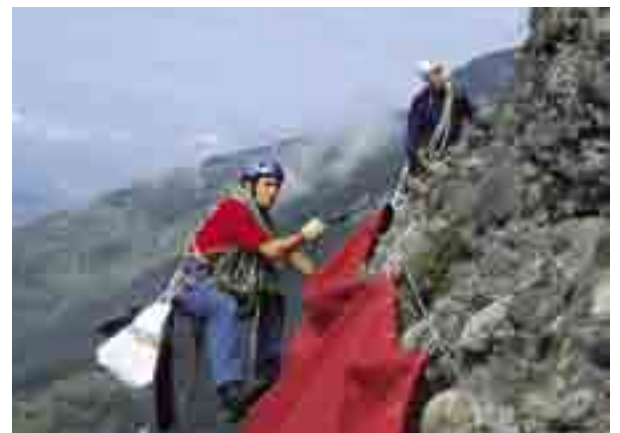
Matthias Oelhafen (links) und Dani Baggenstos bei der kräfteaubenden Montage.
