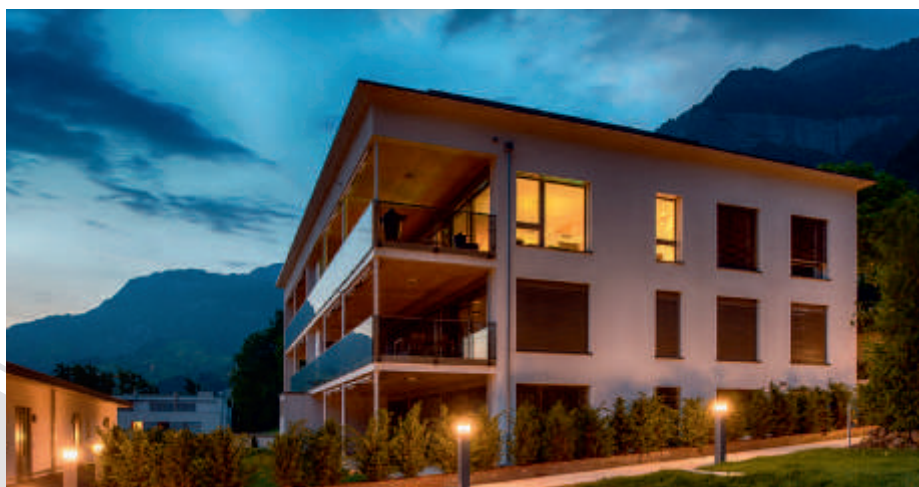
Architektur & Holzbau als Gesamtleistung
